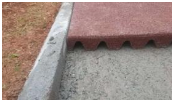
Figura 33 Conferir nível da base com o nível do piso emborrachado.
