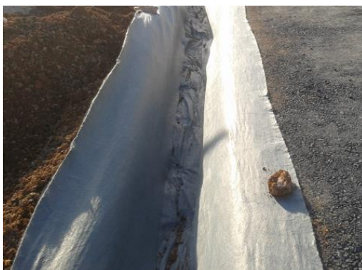
Figura 7 Colocação da manta geotêxtil no fundo da vala
