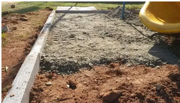
Figura 31 Execução de base em pó de pedra
