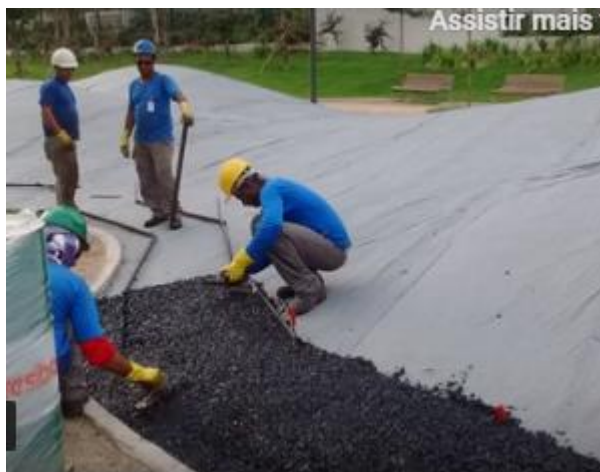
Figura 34 Instalação da primeira camada de piso emborrachado
