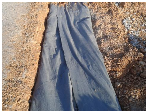
Figura 9 Fechamento da vala com manta geotêxtil
