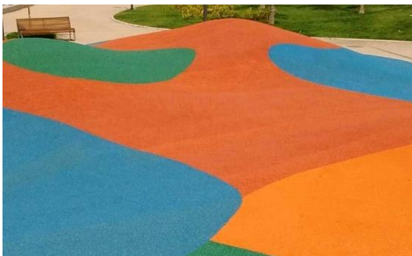
Figura 37 Piso acabado, com esperas para instalação de playground
