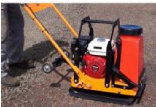
Figura 32 Compactação de base em pó de pedra
