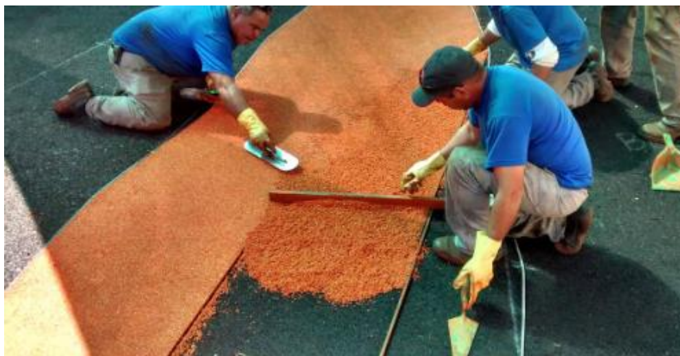
Figura 35 Assentamento da camada de superfície - 2ª camada
